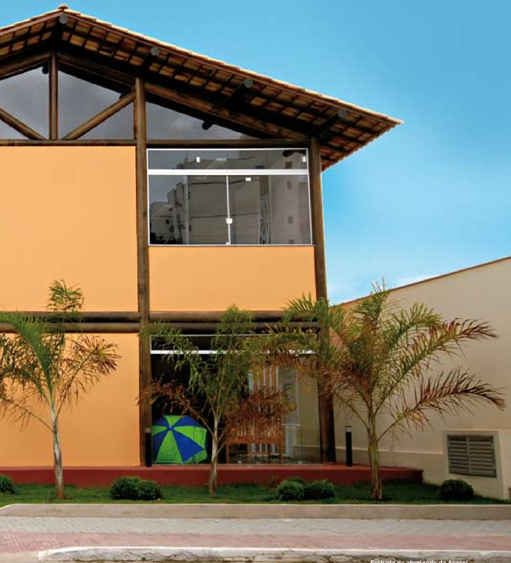
Fachada da atual sede da Acacci
