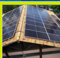
Lançamento da Usina Solar (energia solar)
